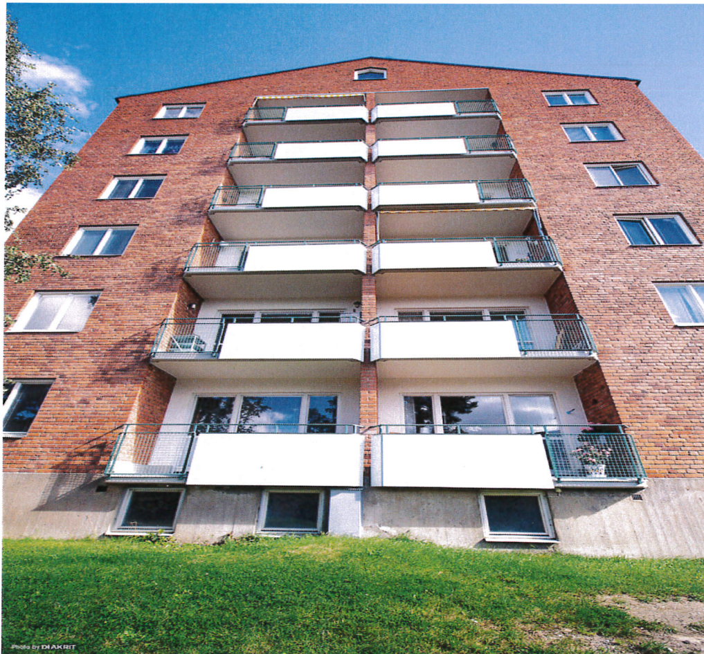
Nyrenoverade balkonger, Torsviksvägen 41, Lidingö
